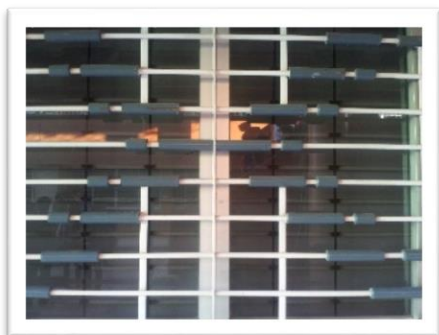
Reforzamiento de estructura metálica
